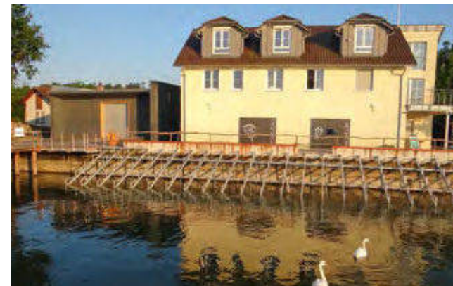
► Abb. 21: Sitzstufen am Ufer im Bau 2013.
